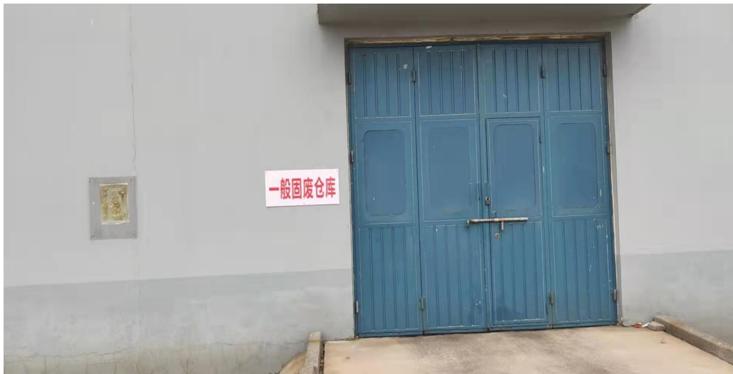
附图 6 一般固废暂存库
